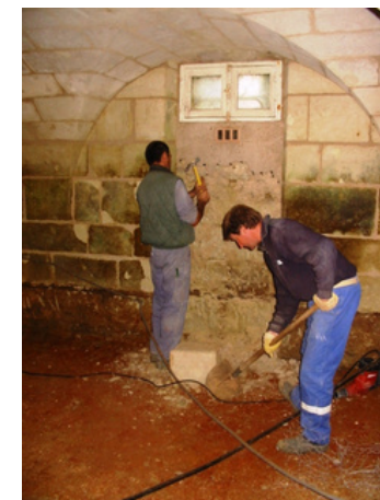
Purge des murs abîmés
