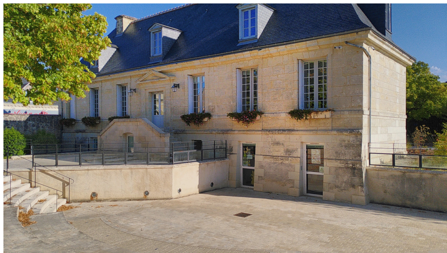
La Grand'Maison en 2026. Au rez-de-chaussée, les bureaux du maire et des services internes et la salle du conseil, au rez-de-jardin, la bibliothèque municipale
