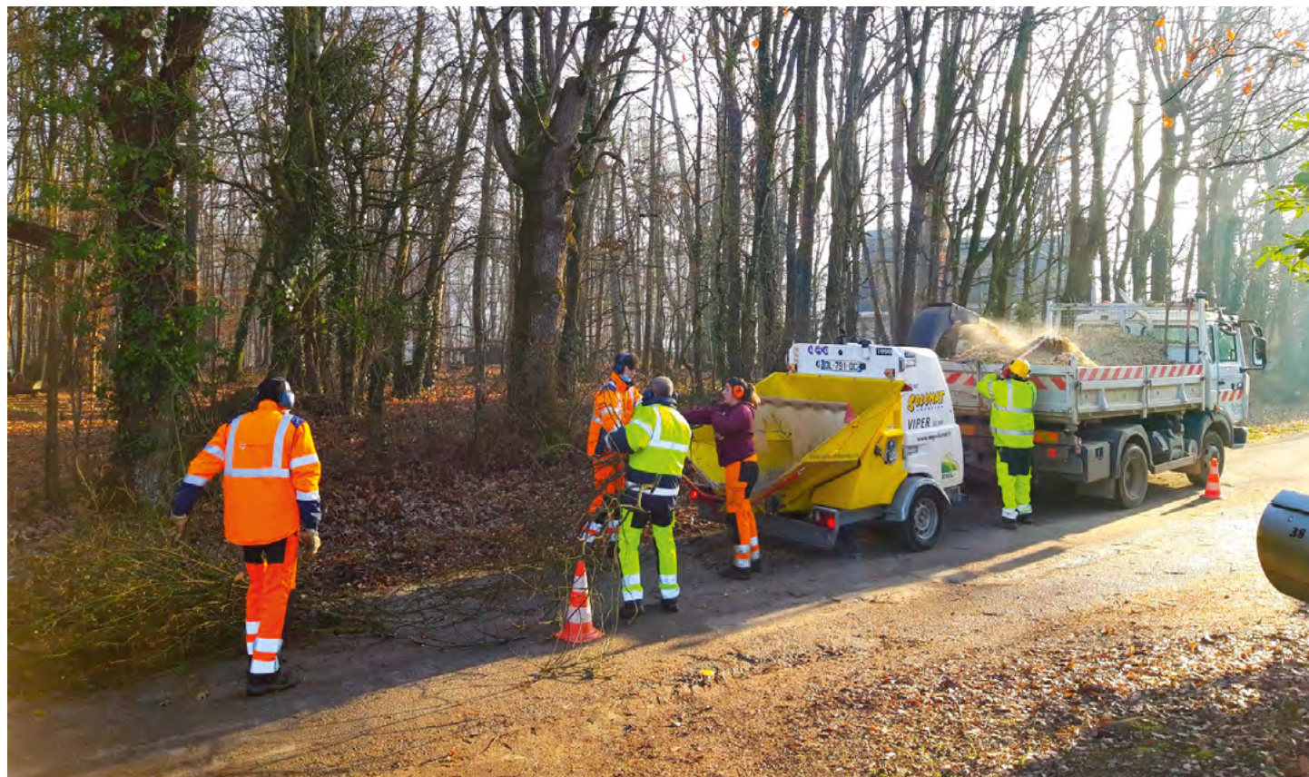
Chantier d'élitage au lamier par l'entreprise DESMET et broyage des branches par les services techniques Rue de l'Étain et Rue de la Chanterie
