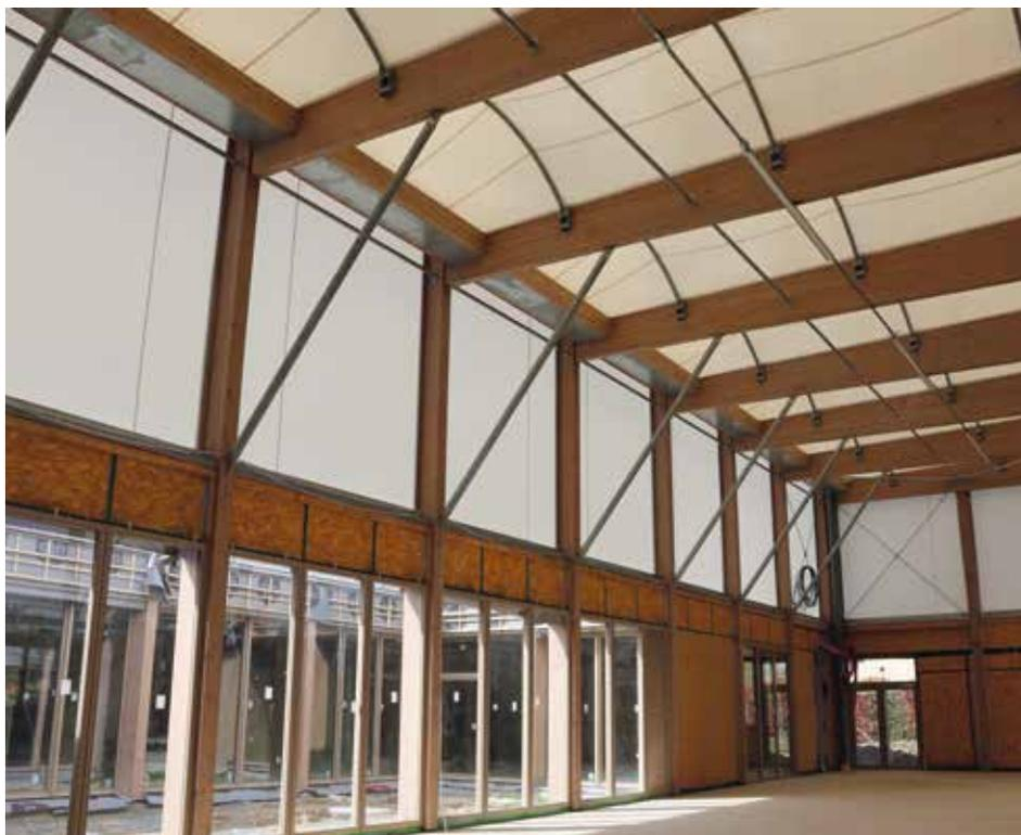
tennis couvert. Il a été conçu en bois et isolé avec des bottes de paille, selon une norme énergétique et environnementale. La finition extérieure en enduit à la chaux assure une performance bioclimatique et les matériaux biosourcés choisis favorisent une ressource locale à faible impact carbone. La pose symbolique de la première botte de paille, le
