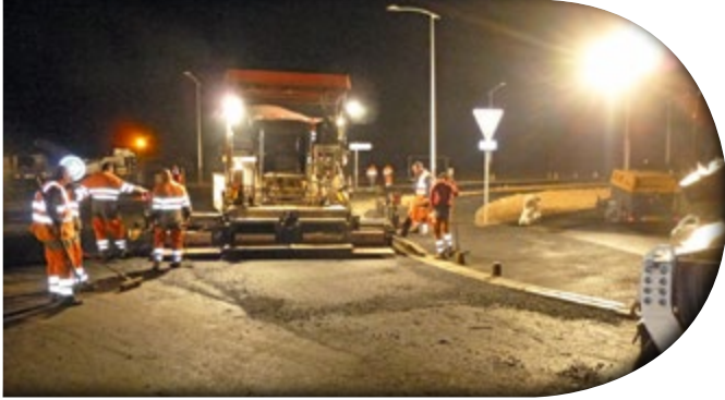
Réalisation du rond-point
