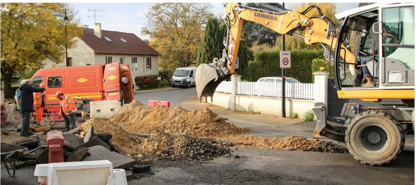
Réseau d'eaux pluviales créé et réfection de la chaussée rue de la Dorerie
