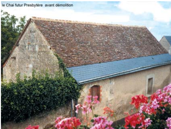
le Chai futur Presbytère avant démolition
