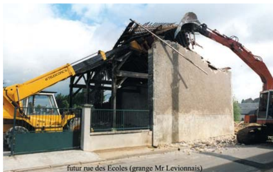
futur rue des Ecoles (grange Mr Levionnais)
