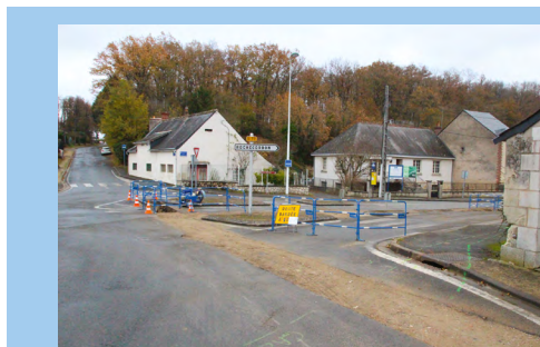
Travaux rue de la Mairie
