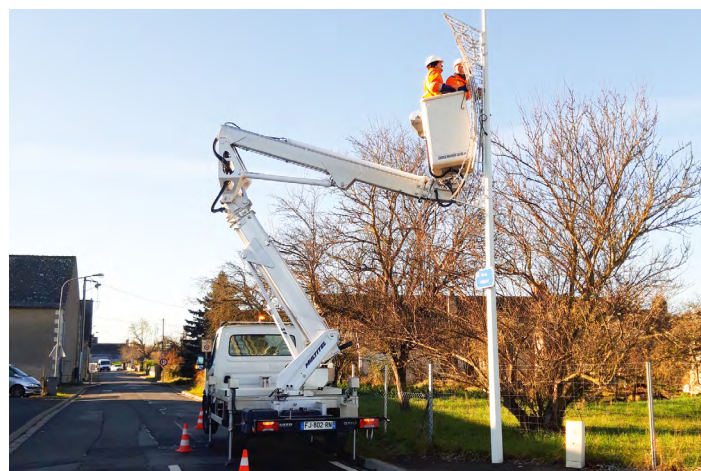
Installation des illuminations de Noël
